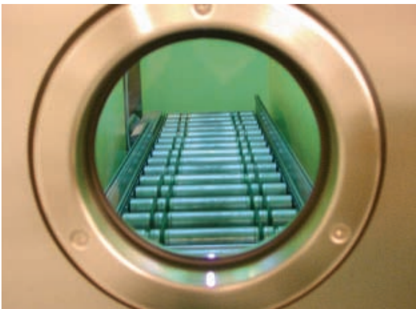
Einsicht in die Schleuse.
